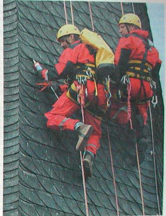
Im Rucksack haben die beiden Dachdeckermeister Ersatzmaterial und Werkzeug dabei.
